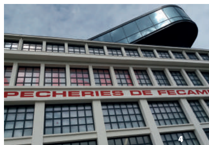
4. Les Pêcheries, musée de Fécamp, béton de la Reconstruction.
