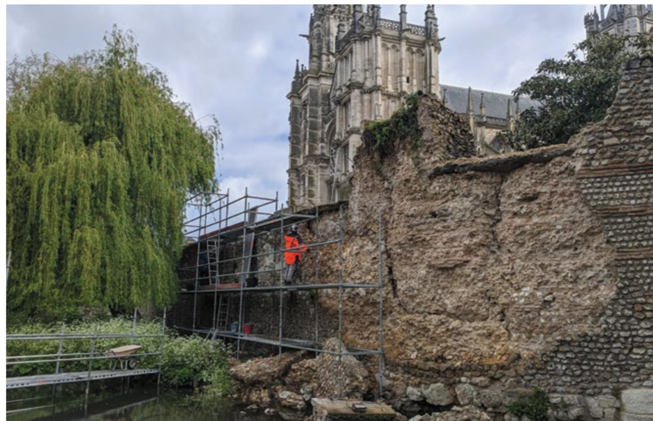
Étude préalable aux travaux de restauration du rempart gallo-romain
