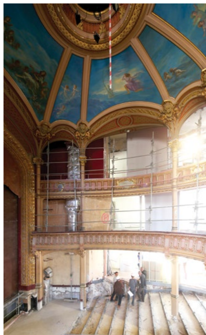
Travaux de restauration du théâtre
