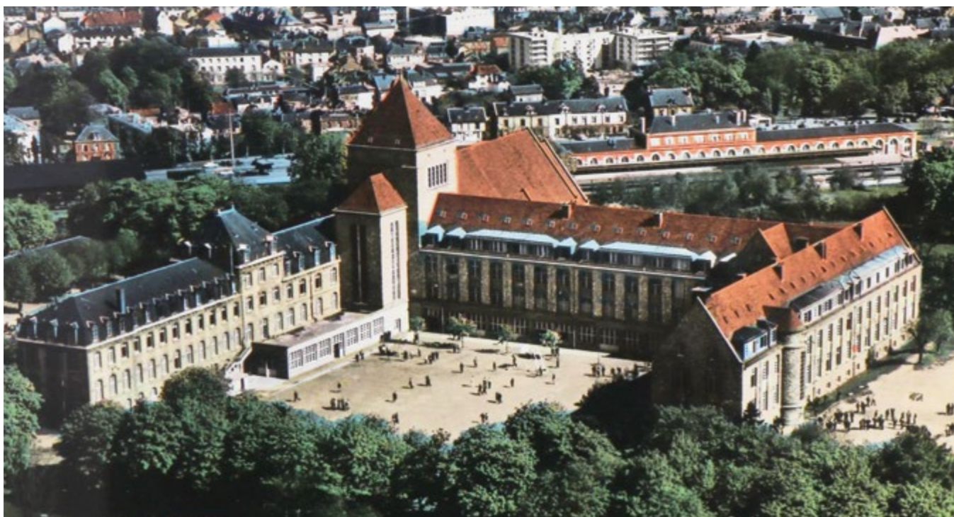
Le lycée Saint-François de Sales reconstruit en 1956
